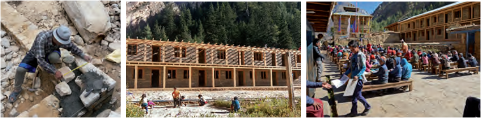
Wiederaufbau rechter Flügel: Verstärkte Ecken mit behauenen Steinen, Rohbau mit Holzstützen, Prüfungen vor der Kulisse des neuen Gebäudes. © S. Lama, M. Kind
