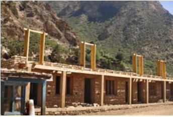
Der Westflügel im Bau...
