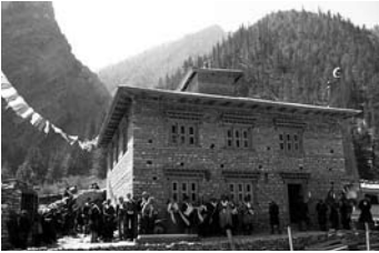
Das neue Mehrzweckgebäude
