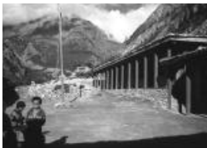
Neuer Schulhausanbau. © 2003 Semduk Lama
